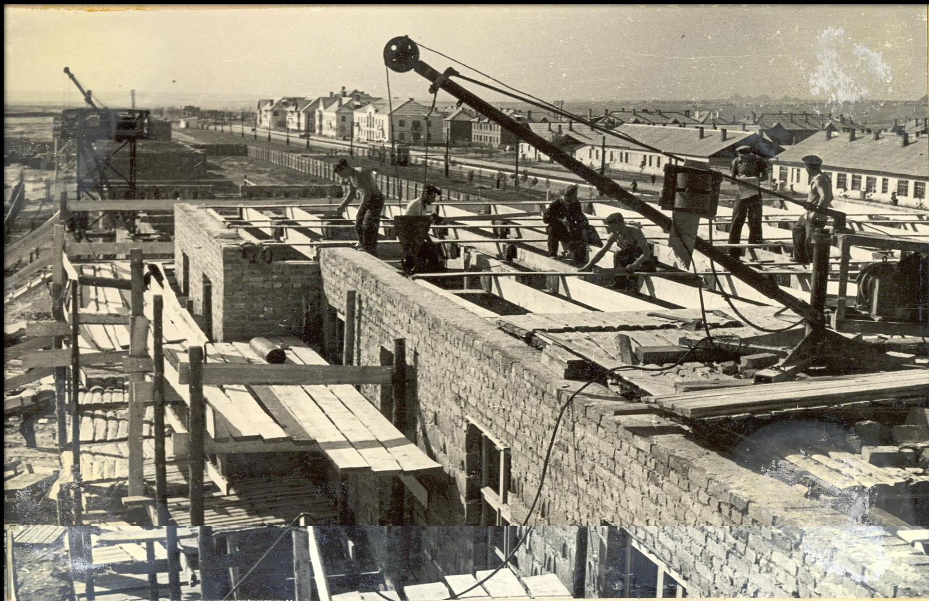
Укладка балок междуэтажного перекрытия жилого дома для строителей канала Северный Донец — Донбасс
