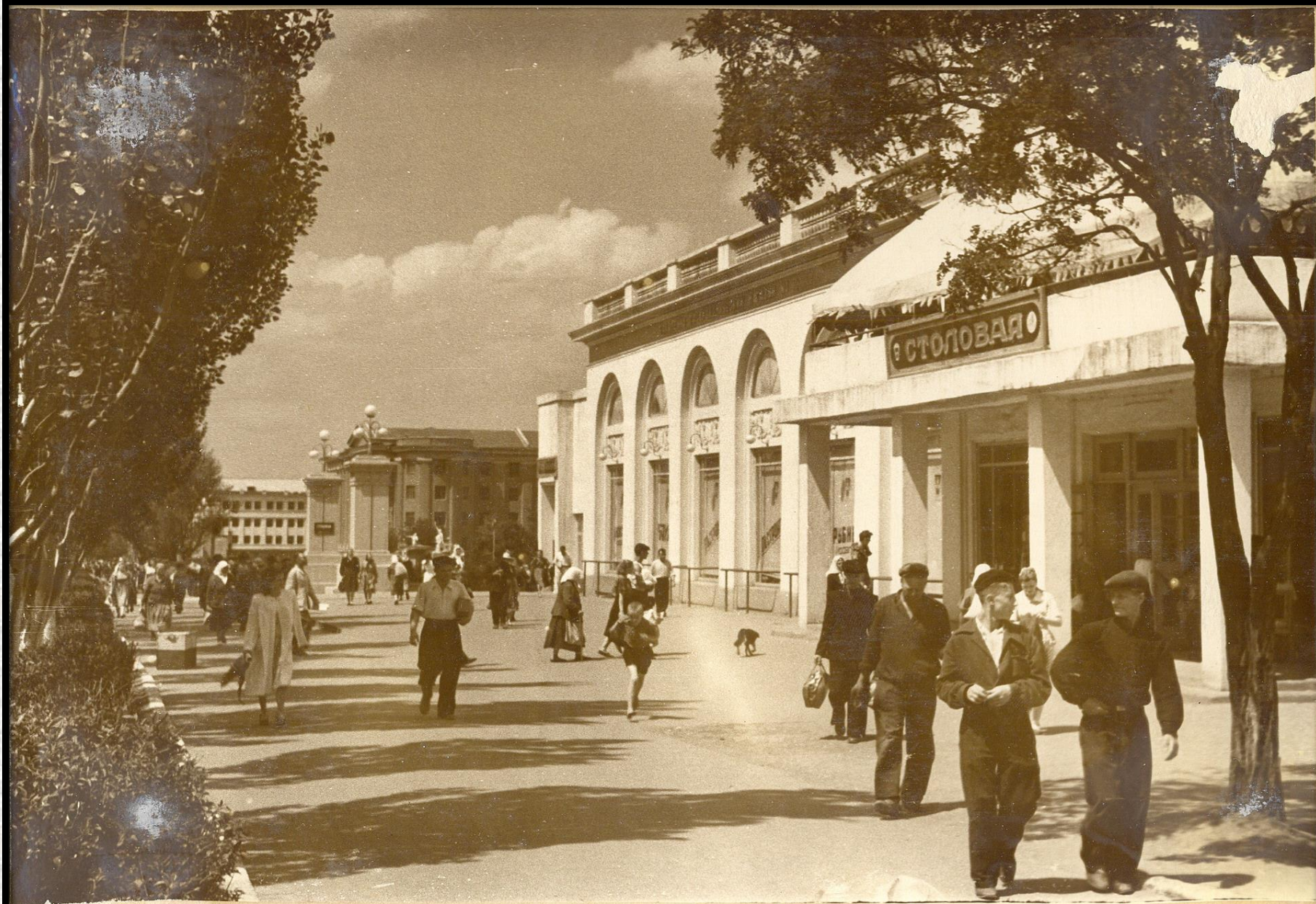
Здание пассажира по проспекту Хрущева
