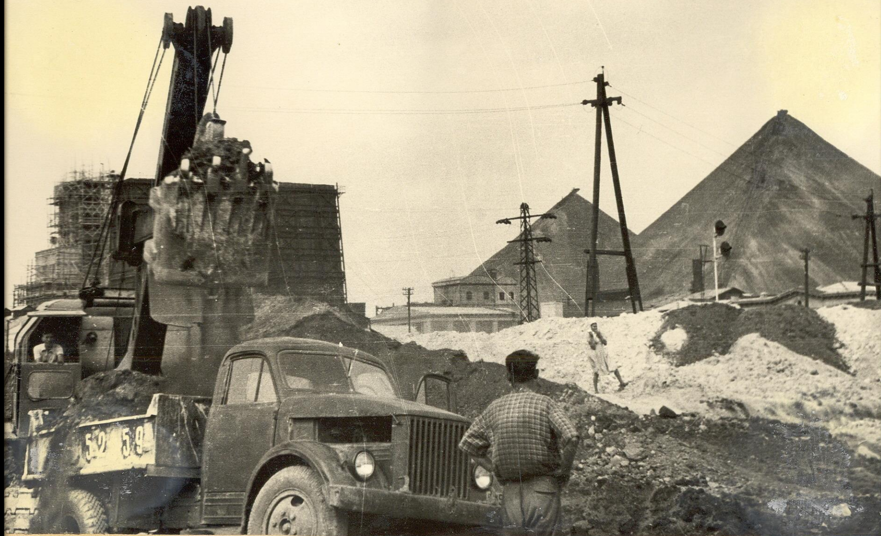
РАБОТА ЭКСКАВАТОРА НА СТРОИТЕЛЬСТВЕ ПУТЕПРОВОДА.
