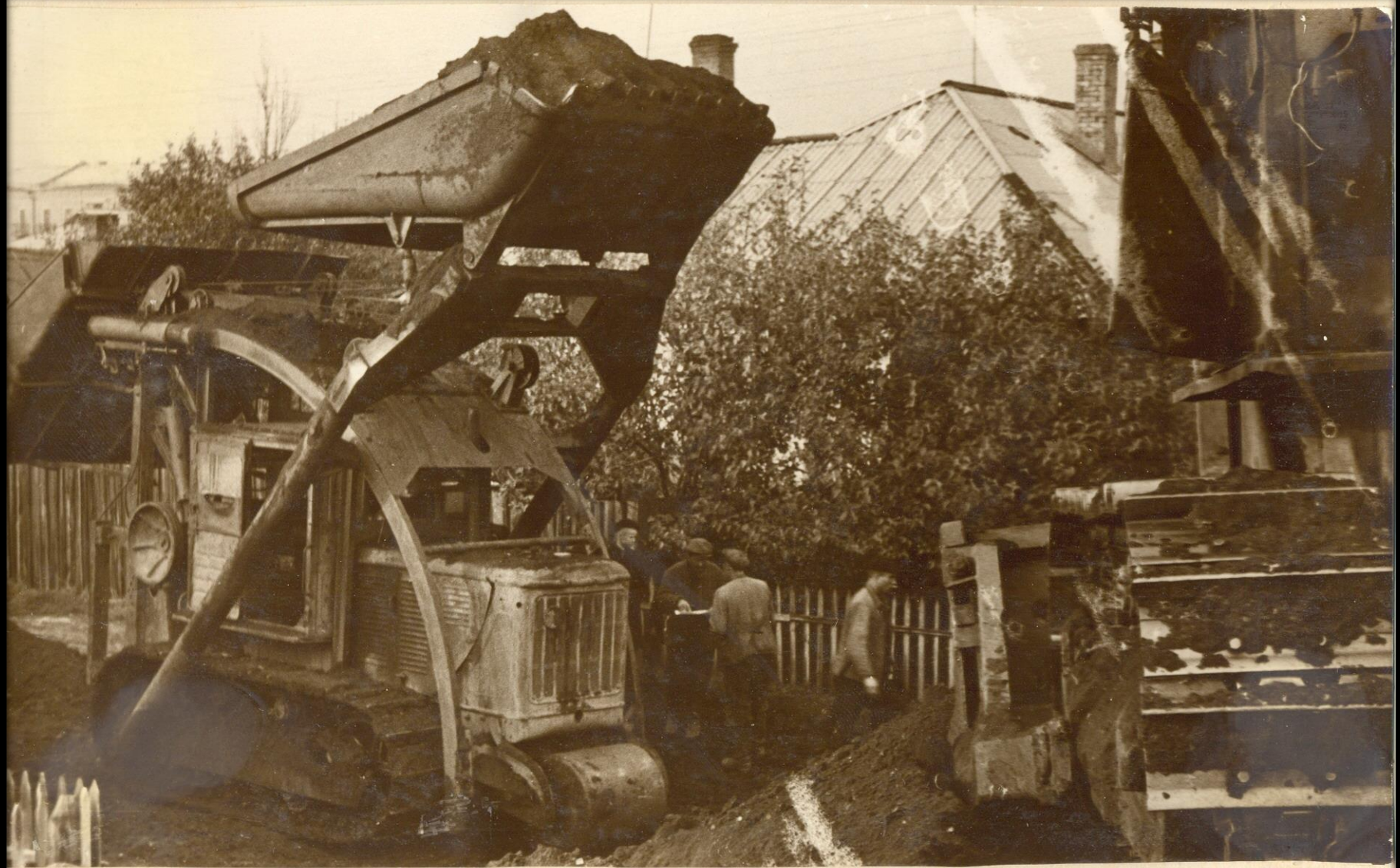
РЕКОНСТРУКЦИЯ улицы ЛЕНИНА
