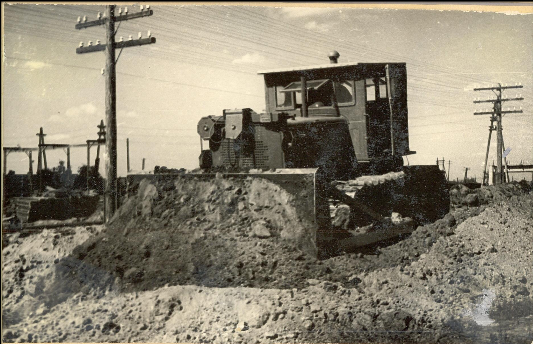
Бульдозер на строительстве путепровода
