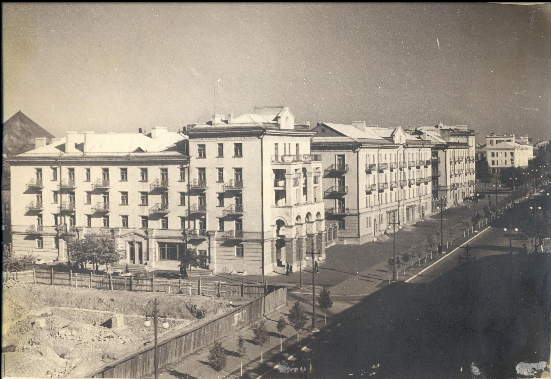
Строительство новых жилых домов по проспекту Победы
